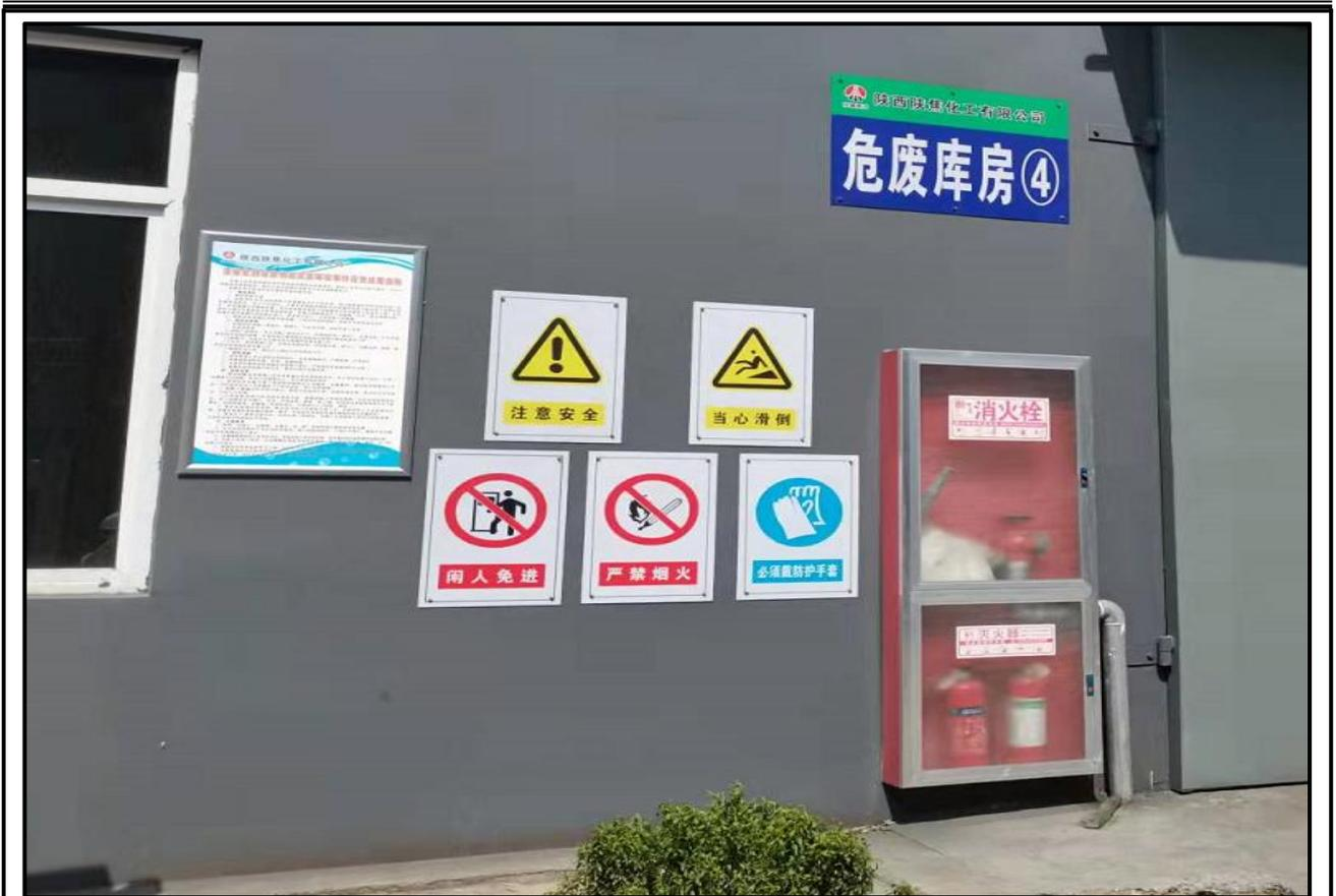
图 7-2 消防栓、灭火器及严禁烟火标识
